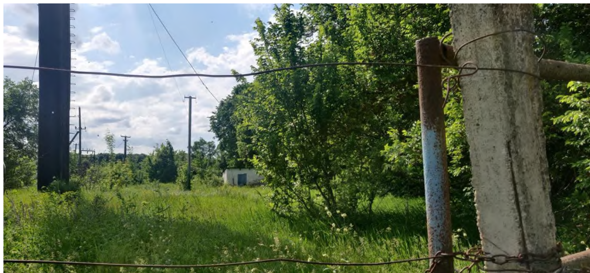
Фотография № 1 – Павильон на устье скважины
