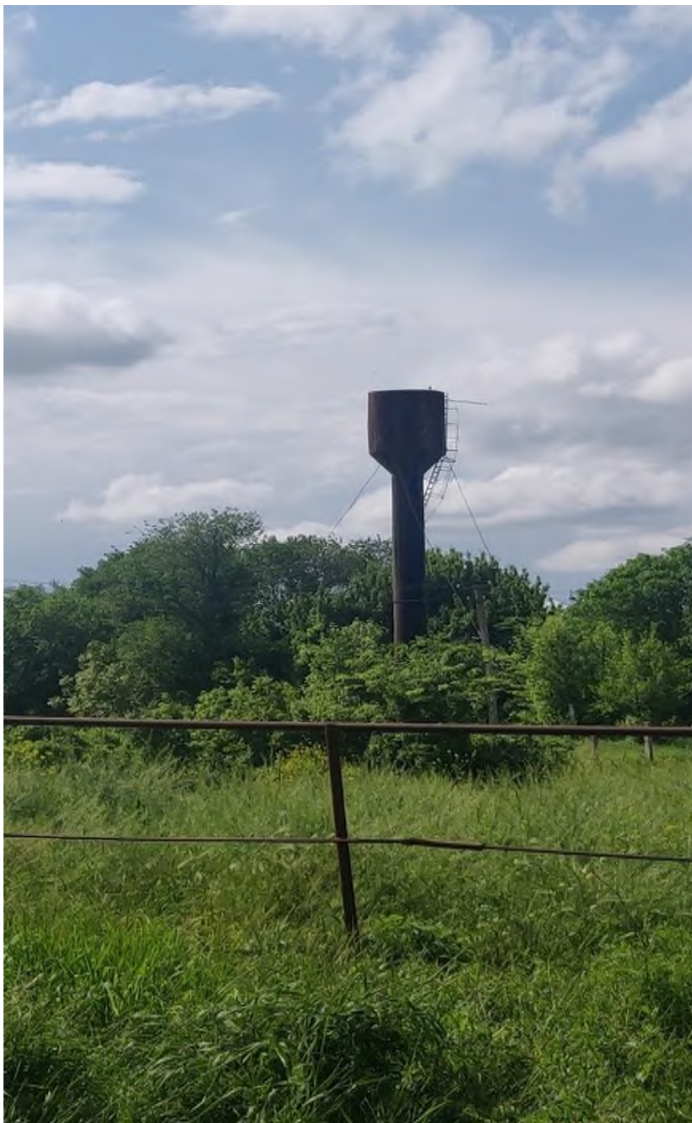
Фотография № 2 – Водонапорная башня
