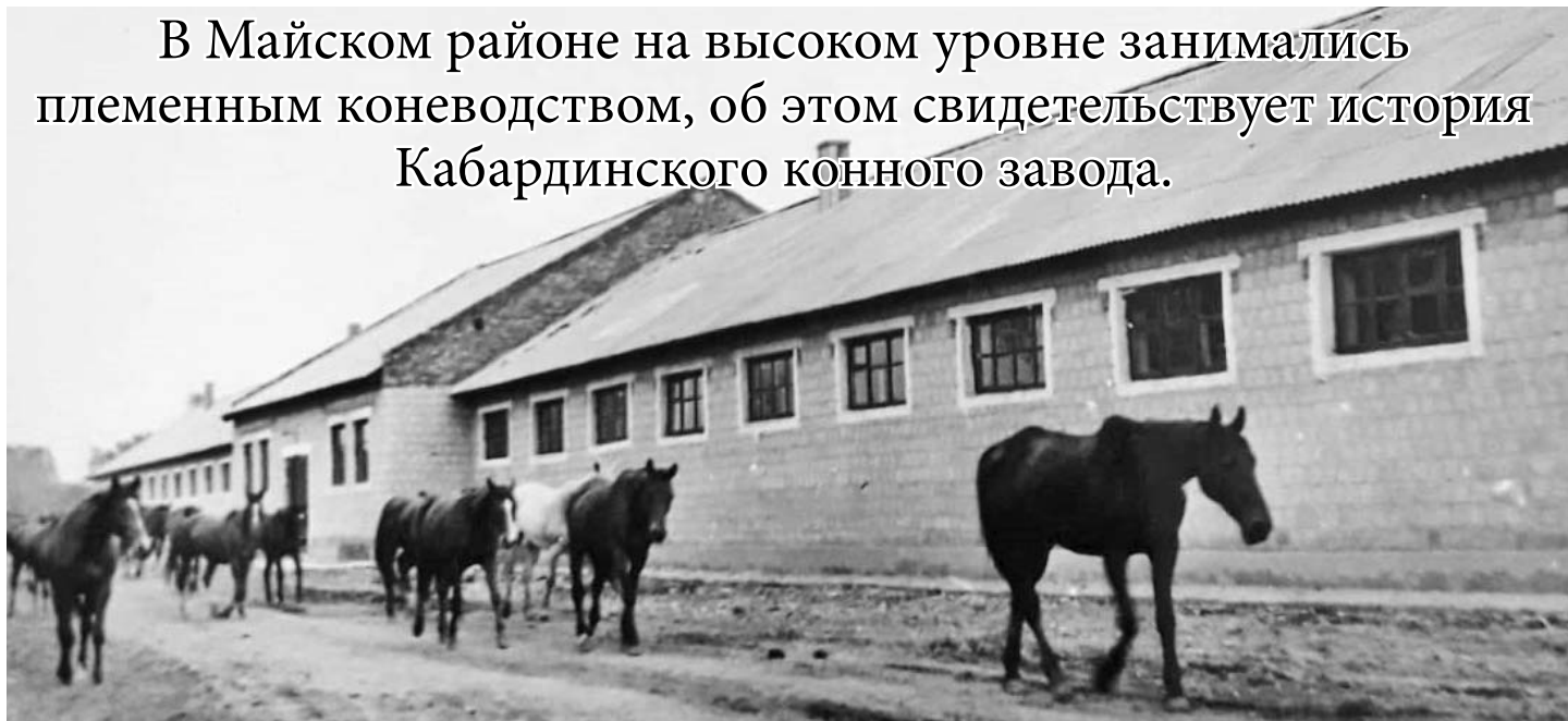
Маточная конюшня конного завода
