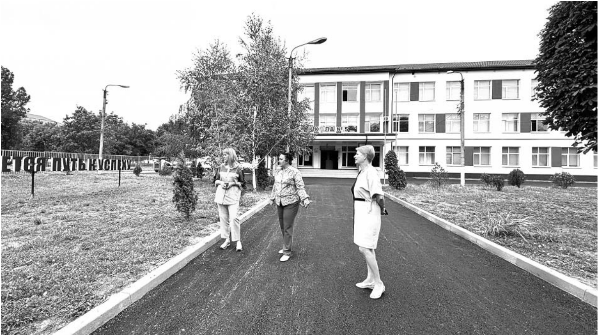
Завершено благоустройство школьной территории: уложено новое асфальтовое покрытие, установлено ограждение боковой части двора. На эти цели были выделены дополнительные средства из местного бюджета района.
